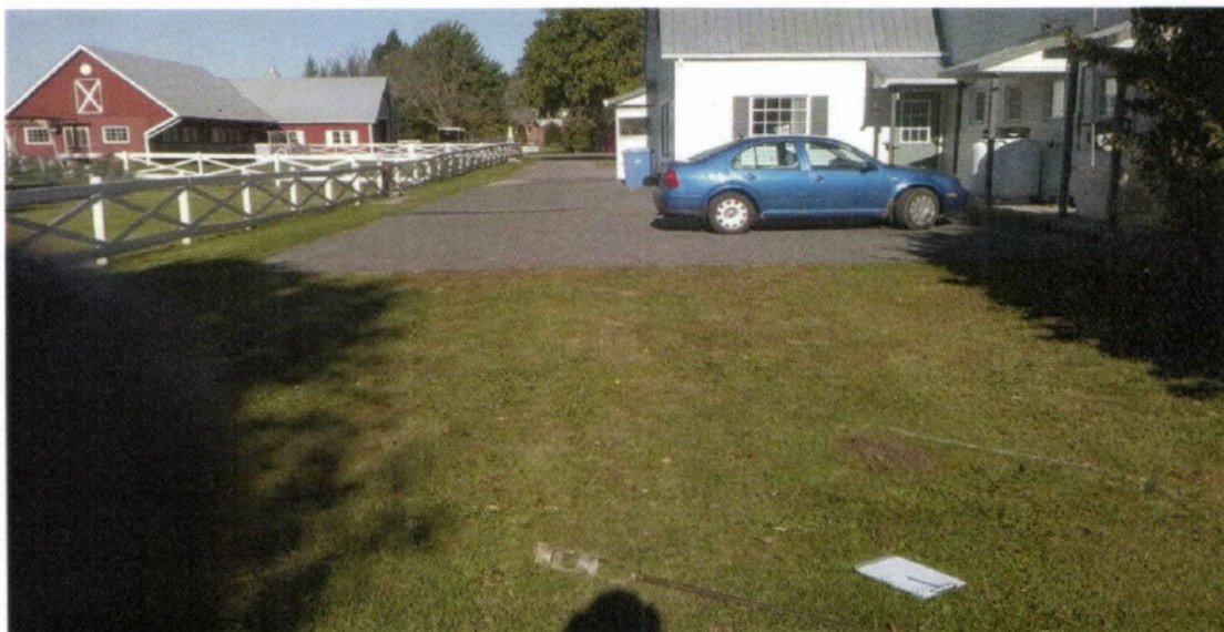
PHOTO 1. Emplacement du bâtiment, de la fosse septique et du champ d'épuration.
